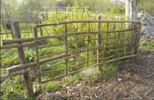
Deze grote poort heeft enkel wat schroeven en hoekijzers gekost. Om te voorkomen dat ze doorbuigt, werd ze met een kabel opgehangen aan de hoge hoekpaal.
