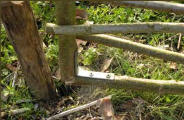
Deze grote poort heeft enkel wat schroeven en hoekijzers gekost. Om te voorkomen dat ze doorbuigt, werd ze met een kabel opgehangen aan de hoge hoekpaal.
